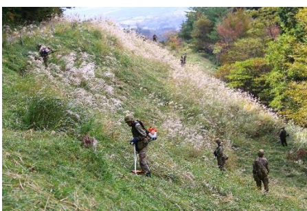
中央停弾堤整備（15即機）
