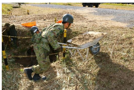
幹線道路等側溝整備（13偵）
