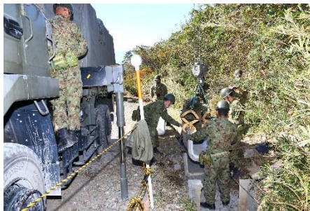
幹線道路等側溝整備（8高群）
