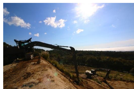
停弾堤整備（14施）
