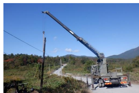
老朽電柱の撤去（中シ通）
