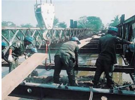
河川への橋梁架設
