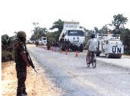
道路補修及び警備
