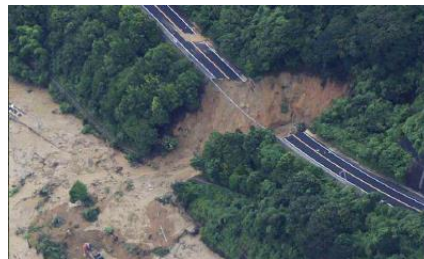
土砂による道路の寸断 （広島県安芸郡坂町）
