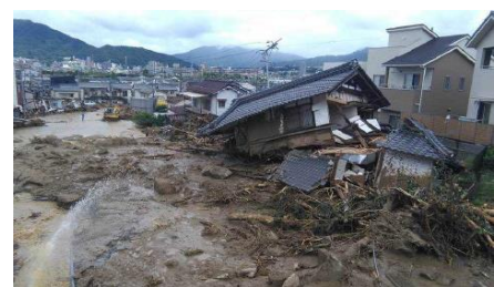
住宅地への土砂の流入 （広島市安佐北区）
