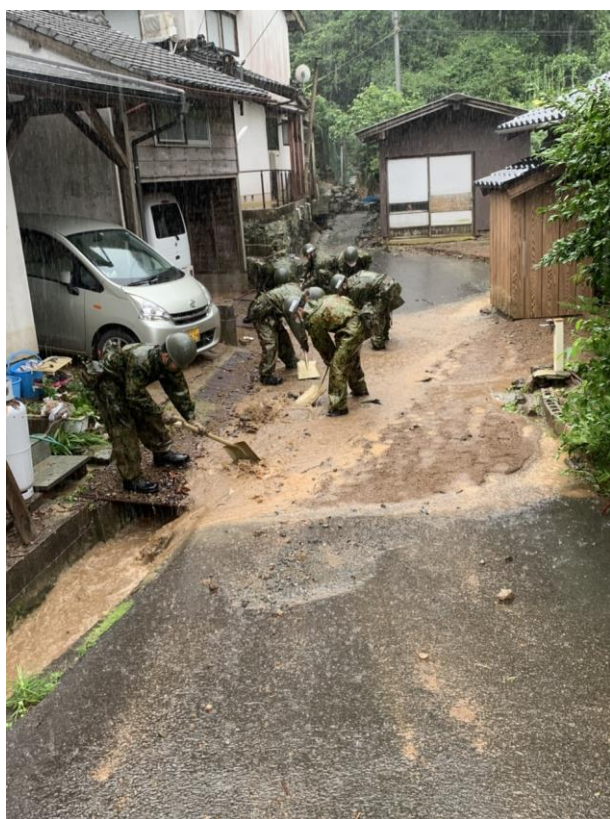
大雨の中の作業
