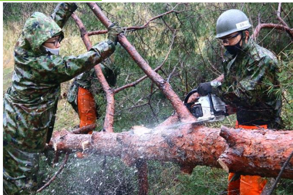
伐採作業（第8普通科連隊）
