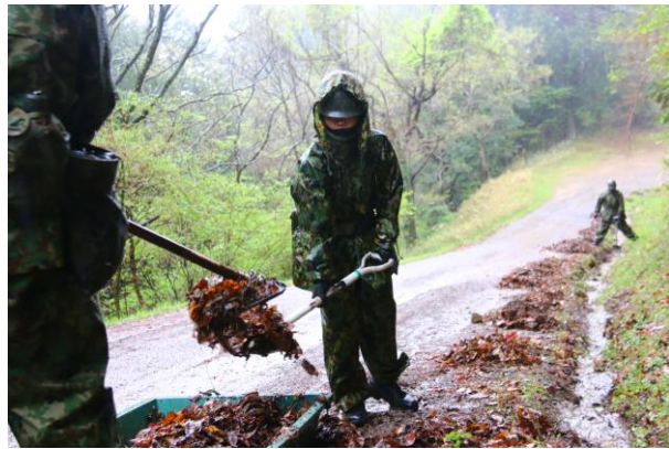
道路等側溝整備（中部方面衛生隊）
