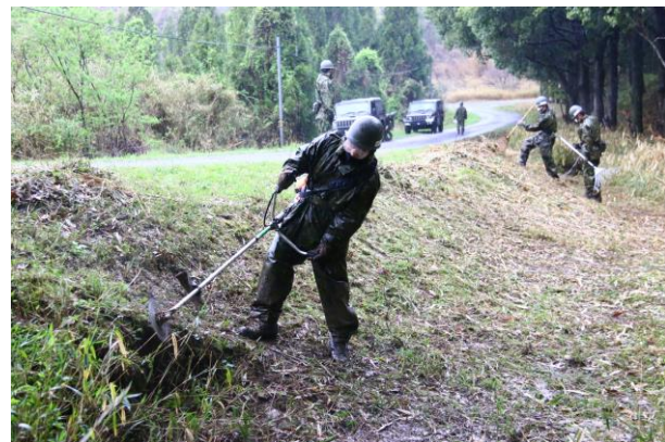
道路等側溝整備（第13偵察隊）
