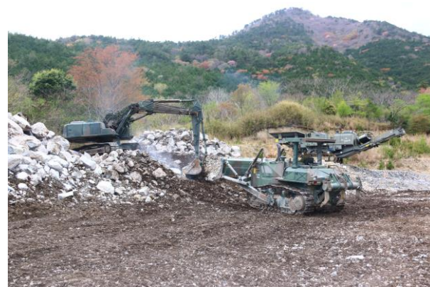
碎石生産（第7施設群）
