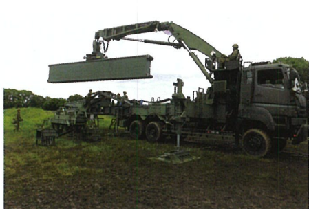
07式機動支援橋の架設
