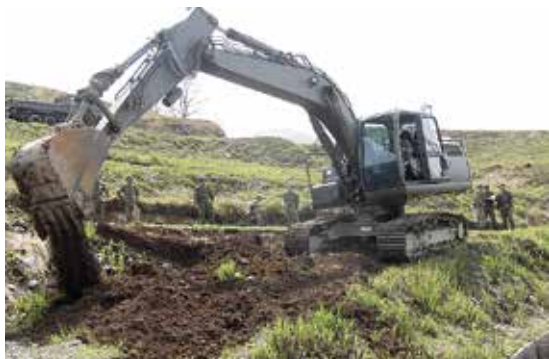
油圧ショベルでの掘削
