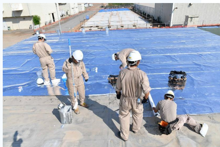
↑ 隊舎が雨漏りしないように防水シートを貼り替え
