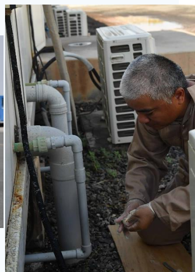
↑ 拠点内の配管の水漏れも隊員が修理をする。
