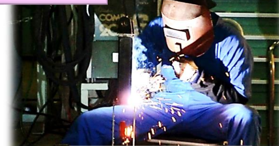
溶接作業（工作工場）
