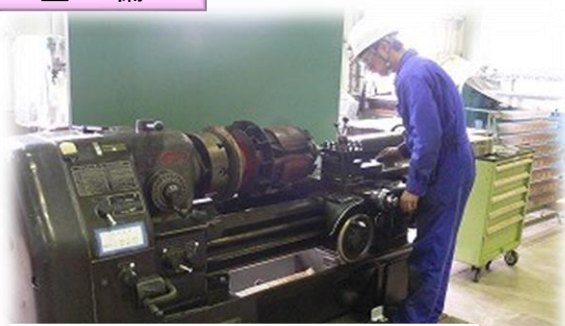
発動発電機整備（工作工場）
