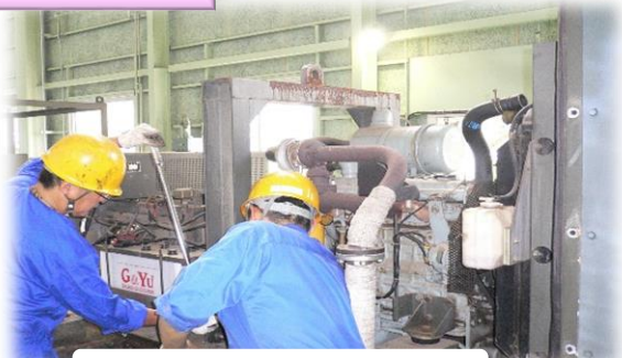
電源車整備（工作工場）
