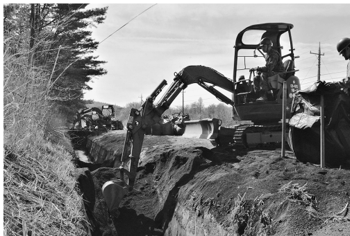
ショベルを使用した側溝の整備
