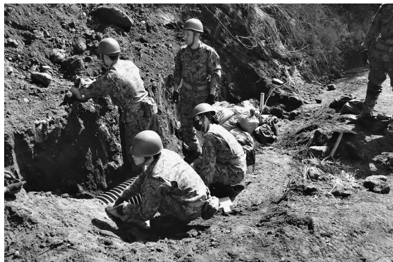
プレスト管を敷設する12化防（相馬原）
