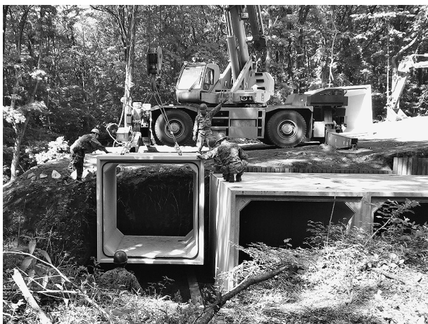
ボックスカルバートを増設する12施設（相馬原）
