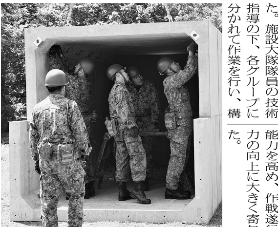
ボックスカルバートを活用した掩体構築
