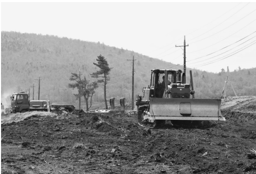
ドーザによる路面整備
