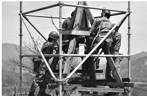
三角点標の改修
