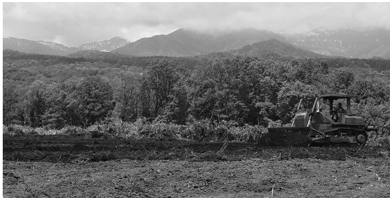
連装銃行進射場の整地作業（関山）
