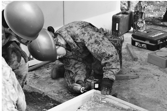
防弾ガラス付きカルバート設置のための基礎作業をする12施設（相馬原）
