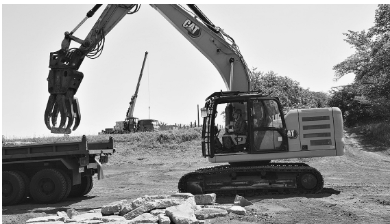
リース器材を使用した瓦礫の積載
