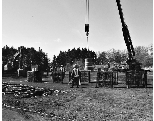
クレーンによる障害物通過
