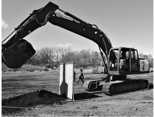
油圧ショベルによる障害物越しの掘削
