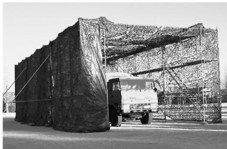
完成した遮蔽設備
