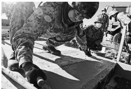
コンクリートを打設する隊員
