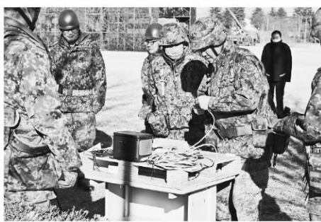
電気（配線）の補修をする隊員
