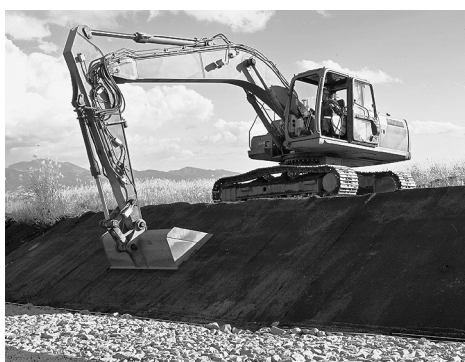
マシンガイダンスによる法面の成形
