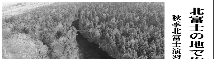
伐根作業が終わり拡幅された「ますみ峠」
