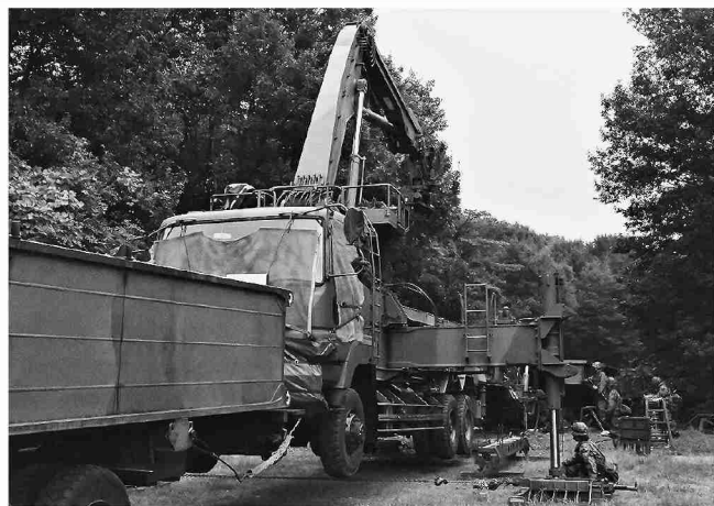
07式機動橋の展開 (12施)
