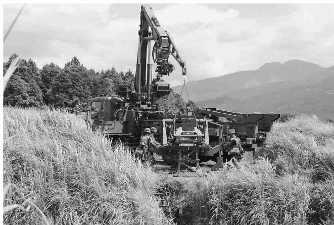
残留住民保護活動に対する施設支援(1施設大:架橋準備)
