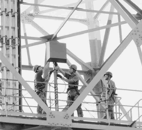
実距離通信訓練（アンテナ設置）
