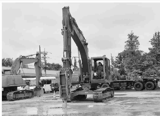
油圧削岩機によるコンクリートの破碎
