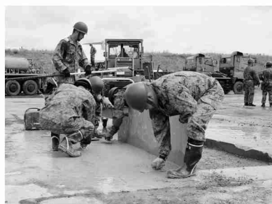
コンクリートの打設
