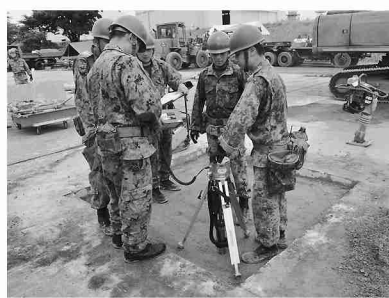
路盤形成後の支持力測定
