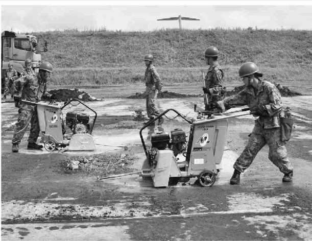
コンクリートカッターによる切断
