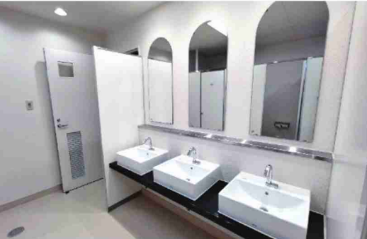
改修された洗面所
