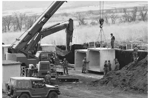
大型重機によるボックスカルバートの設置
