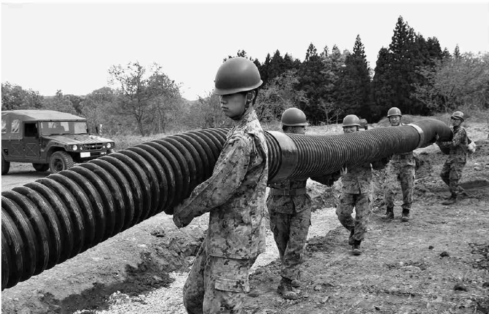
側溝にプレスト管挿入する隊員（関山）
