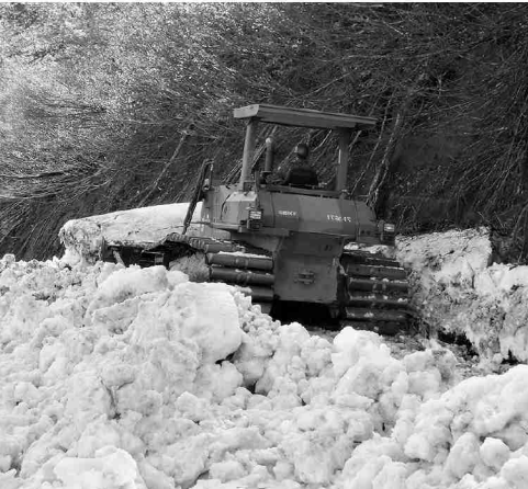
ドーザによる除雪作業（関山）
