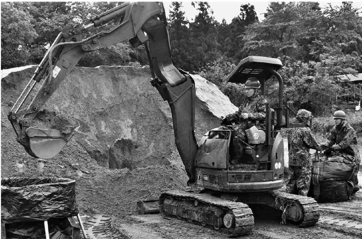
縮尺射場補修を行うための1トン土のう作成（大日原）
