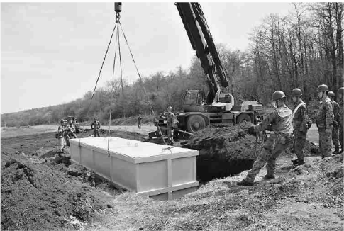
11tの貯水が可能な防火水槽を設置
