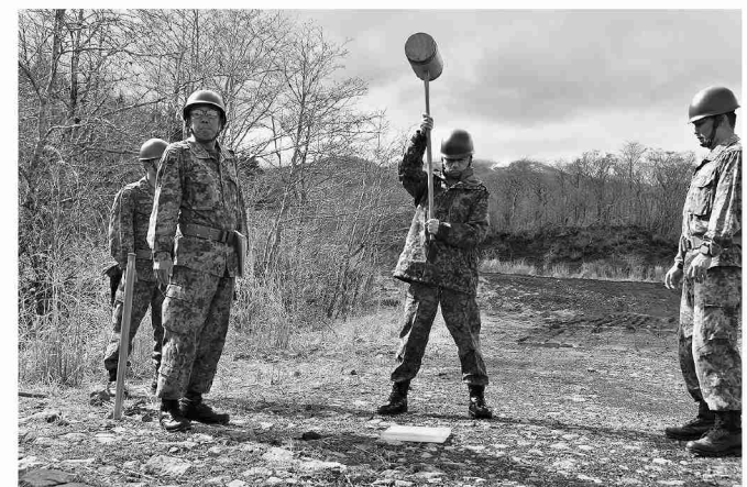
総監による弾性波探査（起振点打撃）体験
