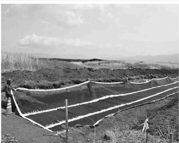
「ジオテキスタイル」工法による路盤補強
