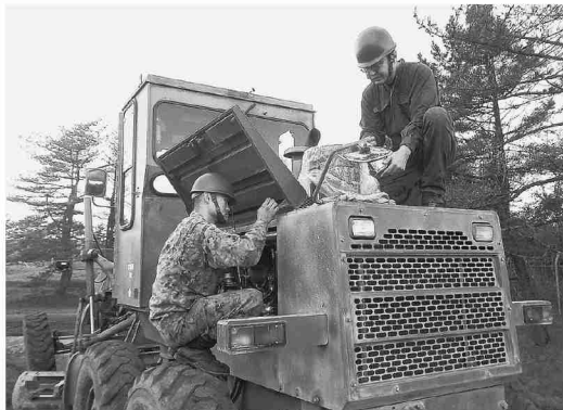
グレーダの故障整備
