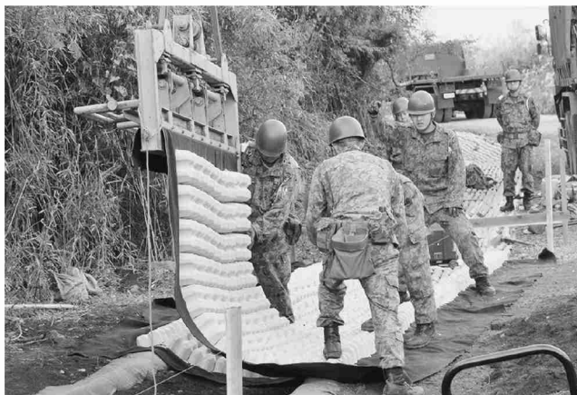
浸食防止資材を活用した平塚道排水設備改修整備
