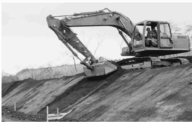
マシンガイダンス付油圧ショベルを活用した機動路拡幅
