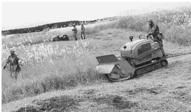
歩行型ナイフ形式草刈り機を活用した除草作業
