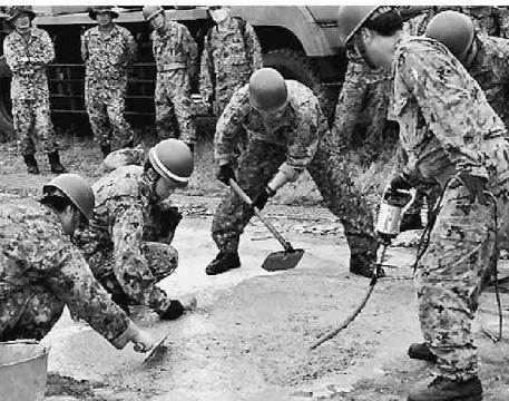
コンクリートバイブレーター（気泡抜き）作業の実習
