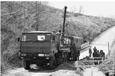
排水設備U字溝の埋設作業(1普連)
