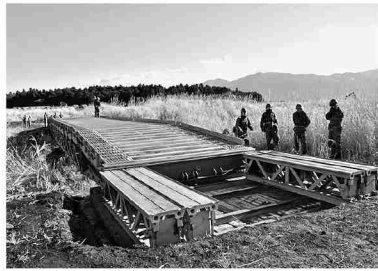
パネル橋MGBの架設(第101施設器材隊)
