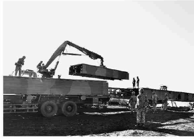
07式機動支援橋の架設(第12施設隊)
