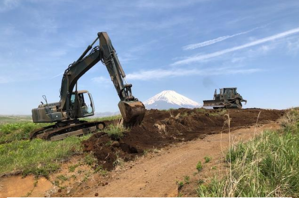
重機による道路の拡幅
