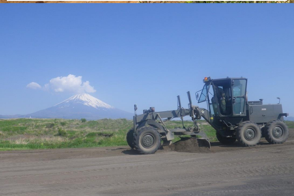
グレーダーによる道路の整地
