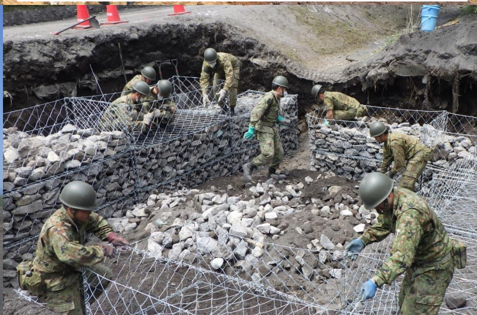
蛇かごによる排水路改修整備
