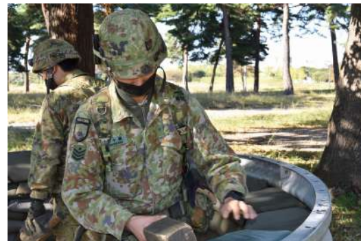
監視哨掩体構築
