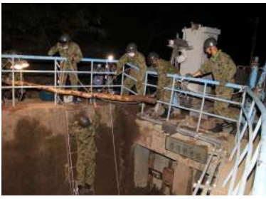
土砂・流木等の除去
