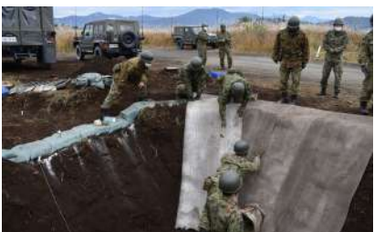
コンクリートキャンパスによる 溜水の整備
