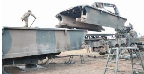
70式機動支援橋の架設
