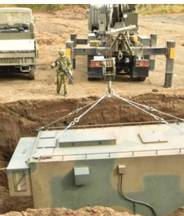
シェルターの埋設
