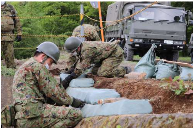
土嚢の設置（1特）
