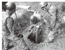
▲土留めの柵作成の様子
