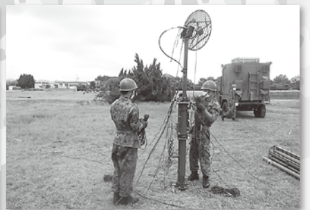
▲アンテナ建柱
