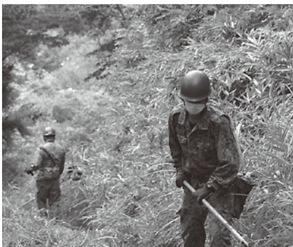
▲演習場内の除草作業
