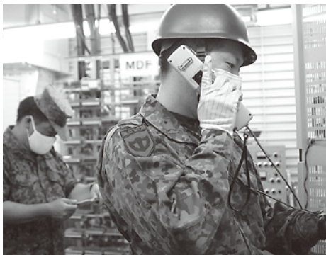
▲他駐屯地との回線点検
