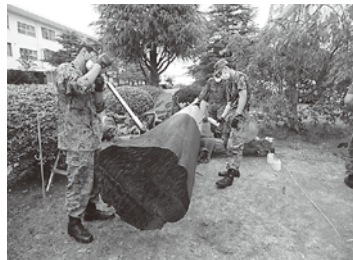
▲焼き付け及び防腐剤塗布
