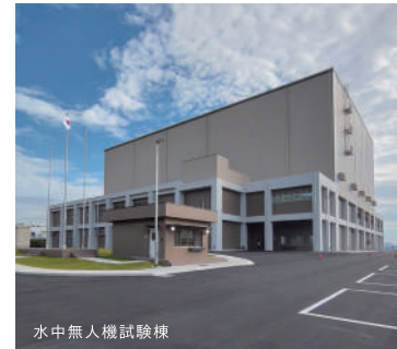
水中無人機試験棟
