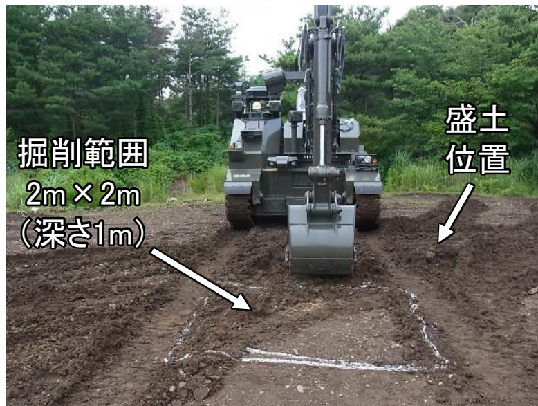
油圧アーム装置(バケット)による掘削
