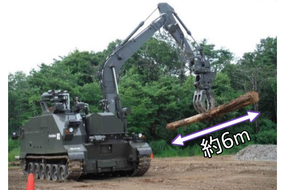
電柱・丸太の通路啓開状況
