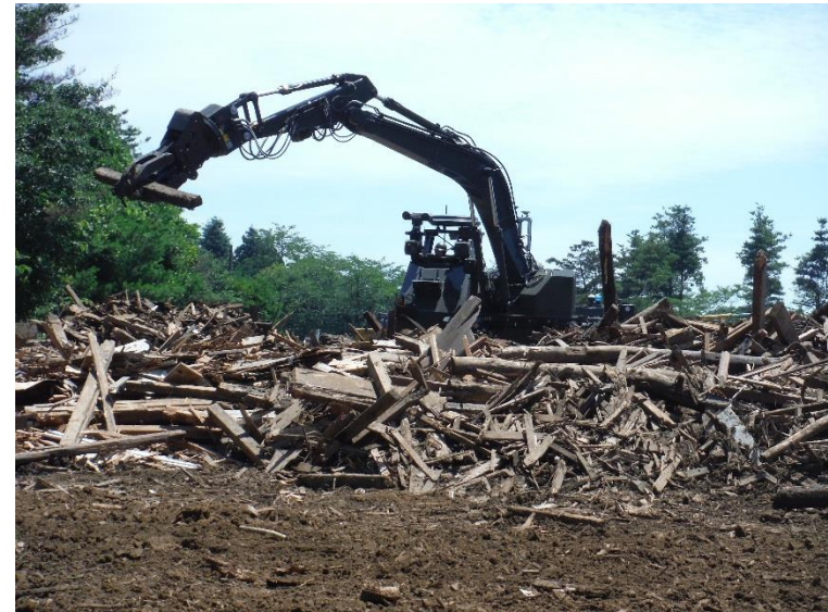
木ガレキの通路啓開状況
