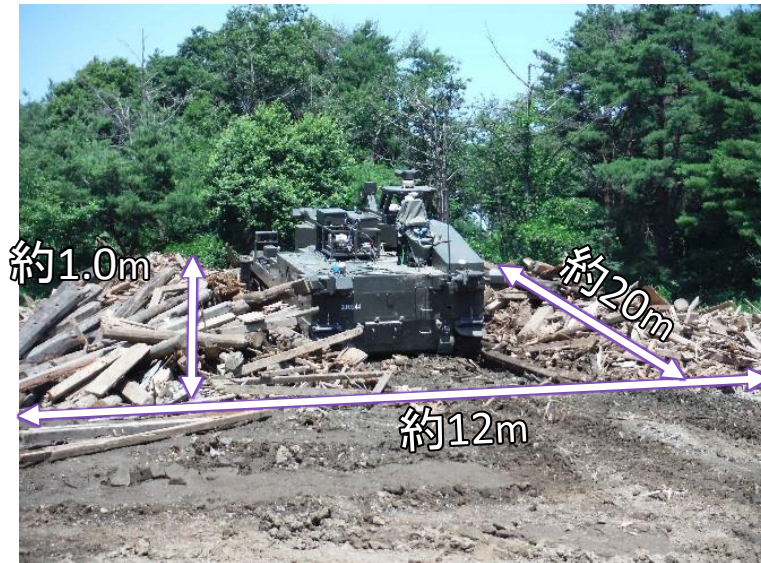
木ガレキの通路啓開状況
