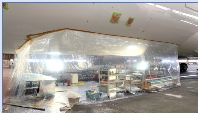
複合材部材の修理 *
