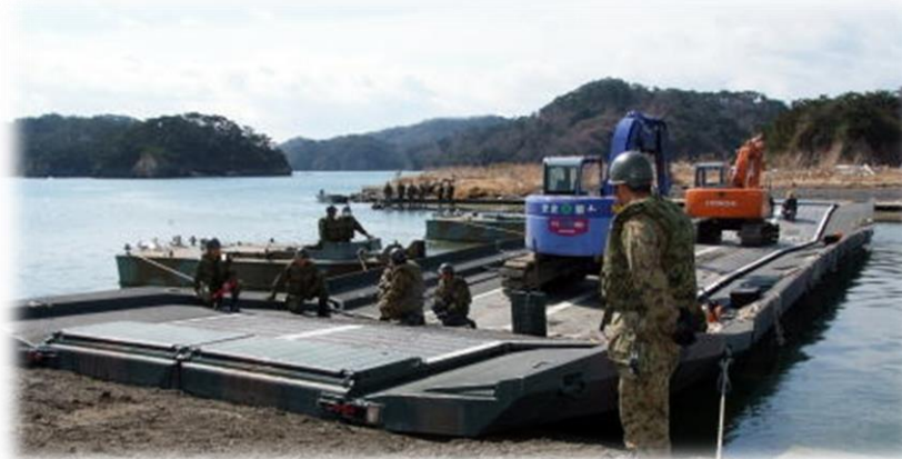
宮城県東松島市で重機を輸送する 92式浮橋 2)
