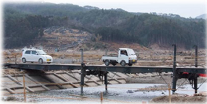
宮城県南三陸町に架設された 81式自走架柱橋 1)
