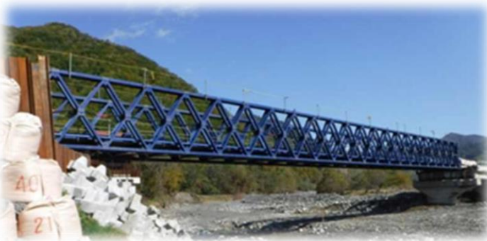
災害現場に架設された民生の69mの応急橋※
