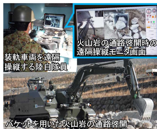
図2 遠隔操縦作業の状況 (雲仙普賢岳無人化施工現場周辺)
