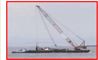
沿岸(約2.5 km) を航行中の台船
