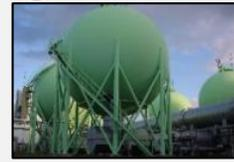
高圧空気源装置から送り出される試験に必要な高圧の空気を蓄える装置であり、合計5基設置されています。各貯気槽は風洞へ空気を供給する際に生じる温度降下(断熱膨張)を抑制する蓄熱体を備えています。
