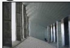
計測部を通過した高速の空気を拡散筒並びに消音塔により減速・消音します。これらの装置により、試験実施中は三音速風洞建屋外部では試験に伴う騒音はほとんど聞こえません。
