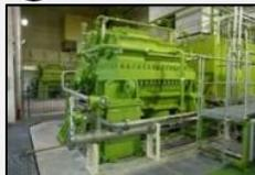
大気より空気を吸い込み圧縮機によって約18°C、7気圧の圧縮空気を製造します。圧縮機はLM1600ガスタービンによって駆動されます。空気源装置はATF、燃風と共用装置です。
