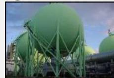
高圧空気源装置から送り出される試験に必要な高圧の空気を蓄える装置であり、合計4基設置されています。各貯気槽は風洞へ空気を供給する際に生じる温度降下(断熱膨張)を抑制する蓄熱体を備えています。
