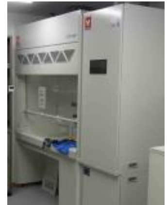
図9-6. ドラフト設備
