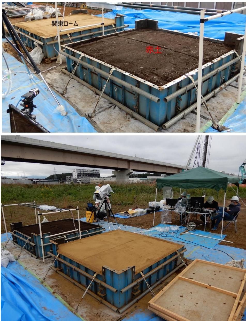
図 3.1.3.3 埋設物試験場の写真(2020年10月12日)
