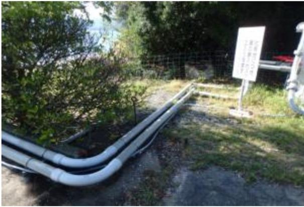
図 5-2-1 1 内径 15mm $\Phi$ ホースによる配管
