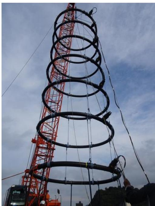
図 56 耐圧容器の吊り下げ方法
