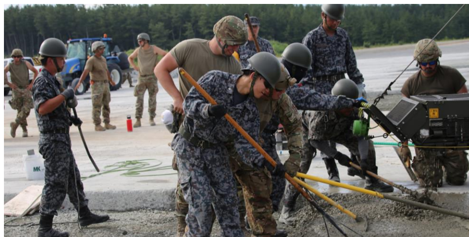
日米滑走路被害復旧訓練
