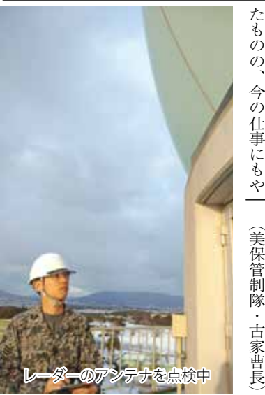
レーダーのアンテナを点検中
