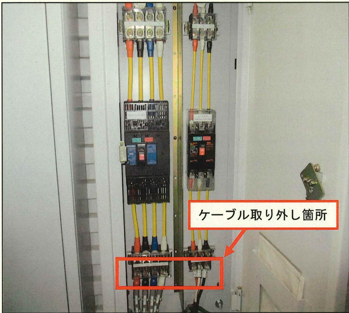
付図5－西側壁配電盤と電源ケーブルの取り外し箇所
