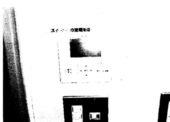
既設空調機（リモコン）
