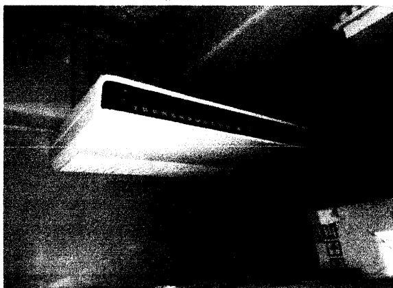
既設空調機（室内機）
