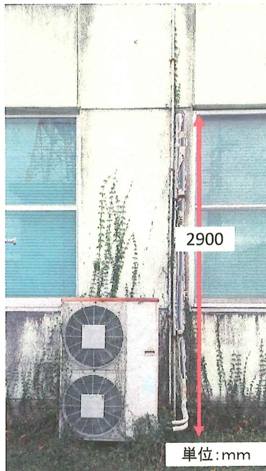
※新規室外機は既設配管穴を利用し、新規に配管及び配線し地上に設置する。
