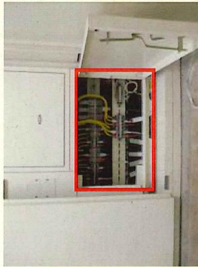
3相電線のターミナルを取り外し、発動発電機から接続された3相の電線を図に示すターミナルに接続する。
